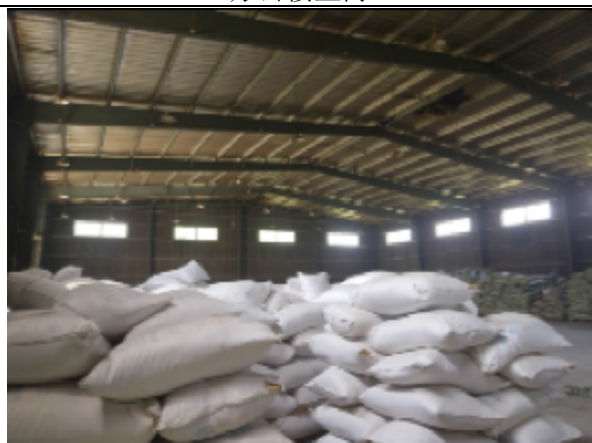
1号车间外观室内
