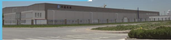
中建廊坊机械制造基地项目
