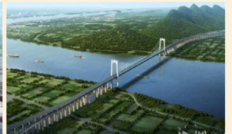
五峰山长江大桥
