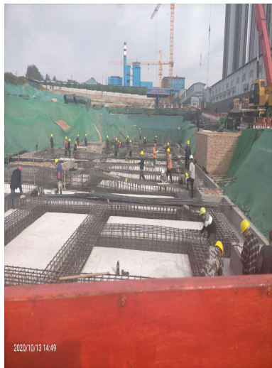
7#楼基础筏板钢筋
