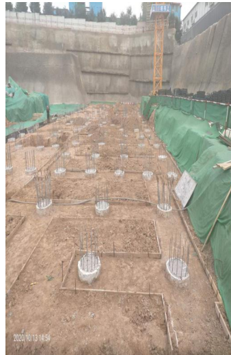
5#土方开挖完成
