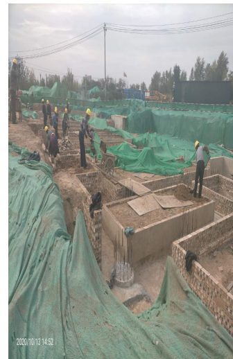
4#楼砌砖胎模完成
