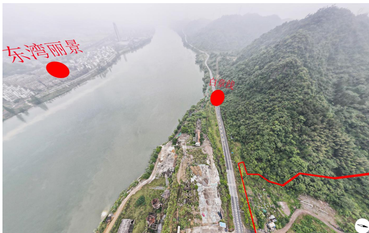
项目现场全景图 2:
