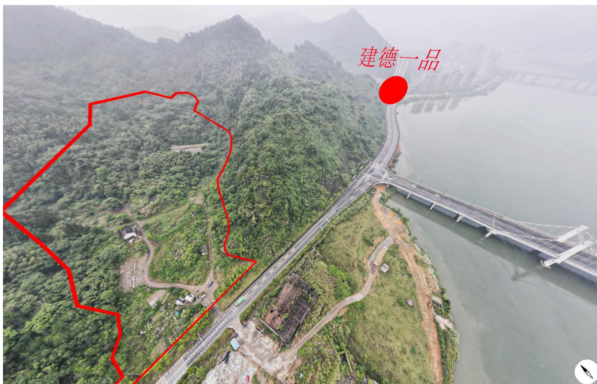
项目现场全景图 1：
