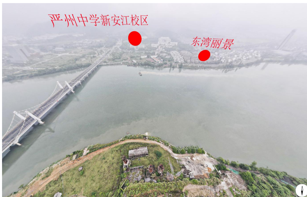
项目主入口处现场全景图:
