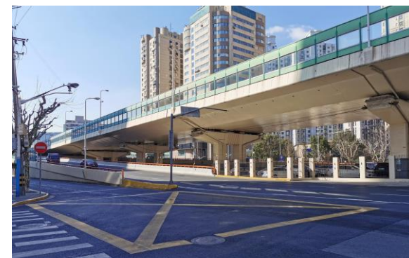
西侧南北高架下匝道
