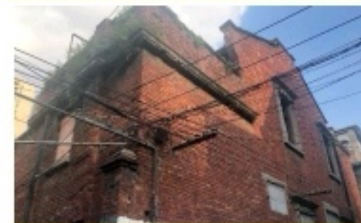
保护建筑(门窗已封闭)
