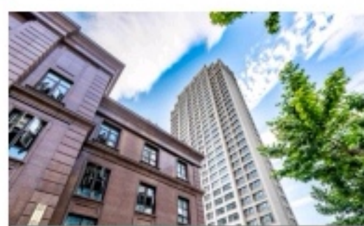
东侧五坊园（现房续销中）
