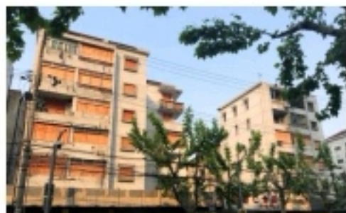
沿街商铺(部分门窗已封闭)
