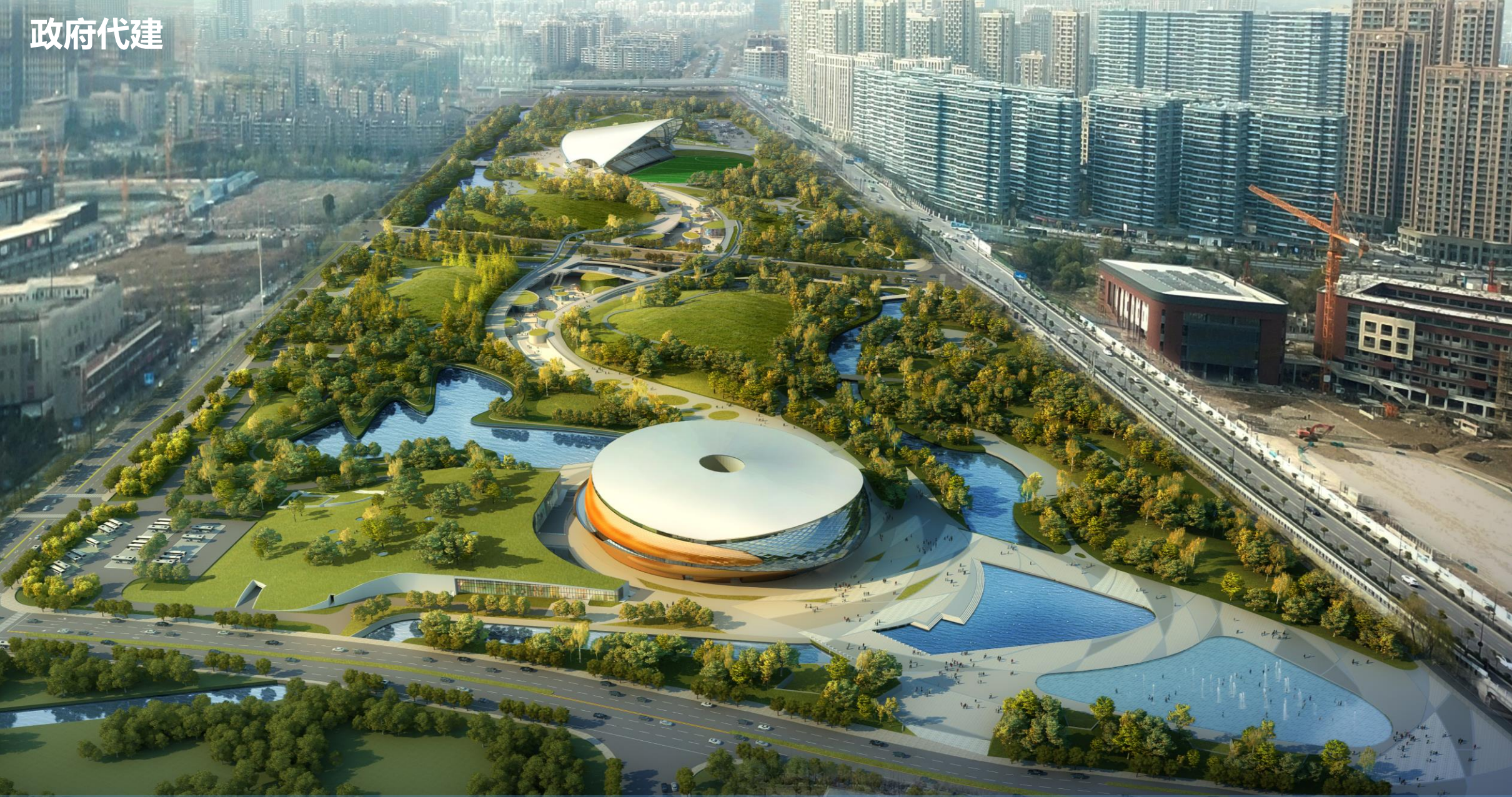
杭州运河亚运公园：是蓝城集团自主运营的大型文化体育生活广场之一，项目总占地701亩，总建面18.5万 \text{m}^2
