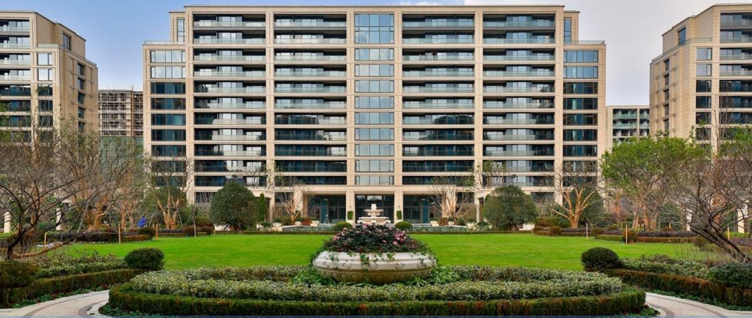
杭州西溪诚园：项目占地465亩，总建面80万方，全石材干挂，直线形体，阳台栏板面采用大面积玻璃，石材的稳重和玻璃的轻盈巧妙融合
