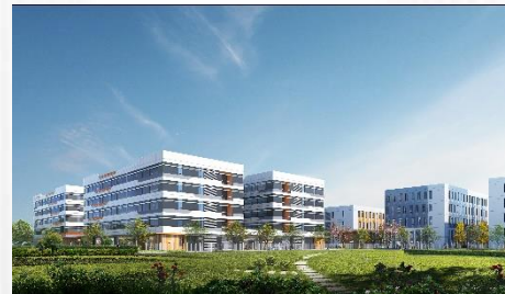
成都·金地威新温江智造园 总建筑面积约13.6万平方米
