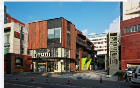
上海·金地威新8号桥（汝南园） 总建筑面积约1.4万平方米
