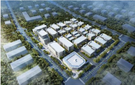
苏州·金地威新吴中智造园 总建筑面积约12.5万平方米
