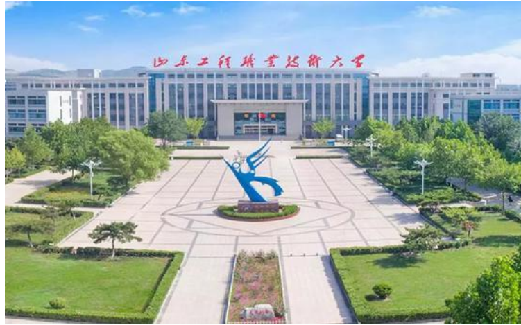
山东工程职业技术大学
