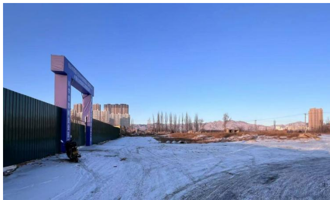
地块西侧紧邻还在施工的幼儿园围挡
