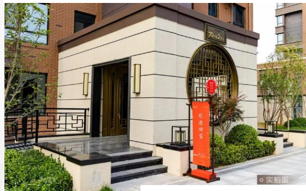
干挂石材和真石漆外立面、全园石材铺装
