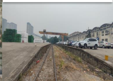
地块东南侧铁路1现状
