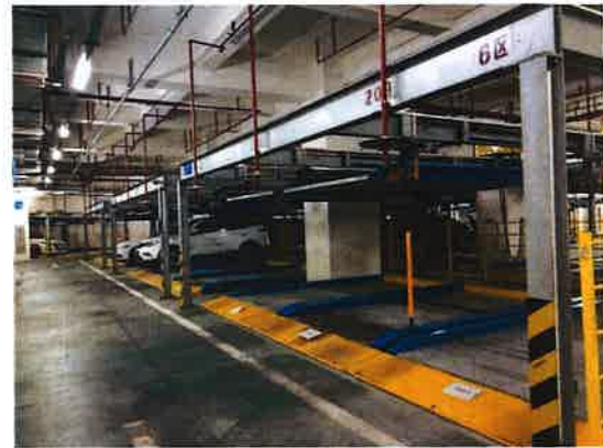
估价对象 B 地下三层停车库
