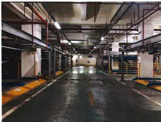
估价对象 B 地下三层停车库
