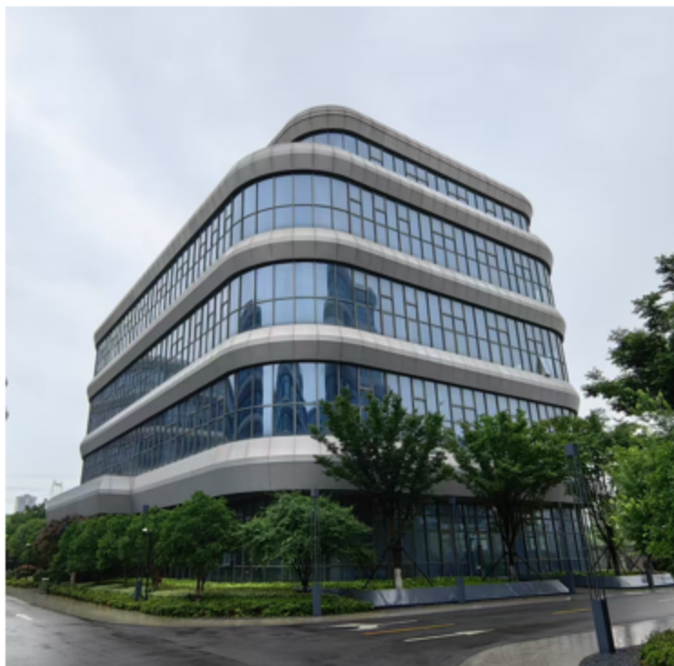
大楼东北侧视角
