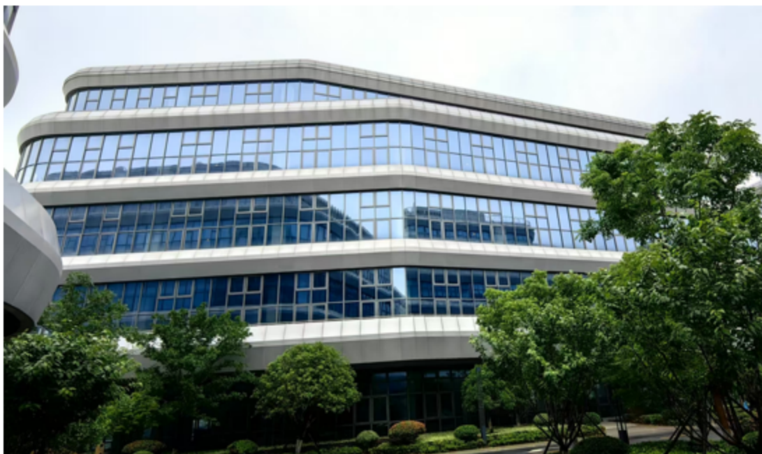
大楼正东面实景图
