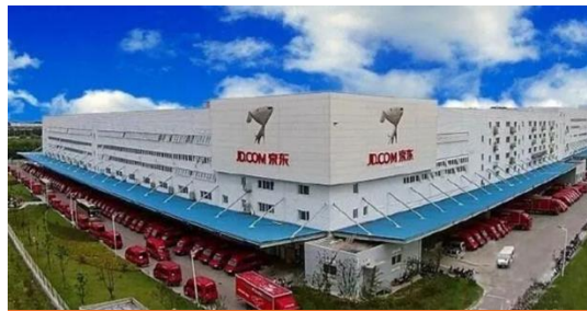
天津东丽二期园区
